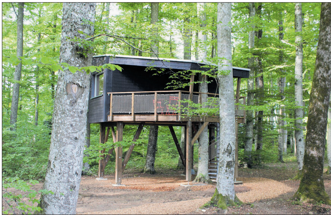
Les Cabanes du Mont, à Coeuve, ont bénéficié du soutien de la structure Talentis LAB.
